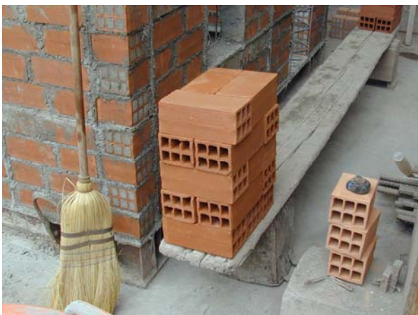
Figura 4. Preparación del muro de ladrillo hueco con perforaciones horizontales de 24x11,5x9,5cm.
