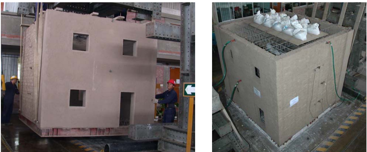
Figure 9. Construcción terminada, empleando sólo barro y con 2 de las paredes enfoscadas, incluyendo la sobrecarga de los forjados correspondiente a construcción mínima.
