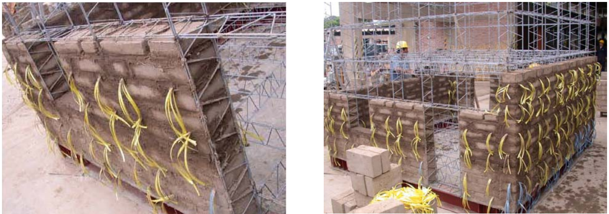
Figure 5. Para la construcción del muro de adobe, se colocan las piezas dentro de la retícula de las cerchas previamente levantadas, dejando sobresalir bandas de agarre para el enfoscado.
