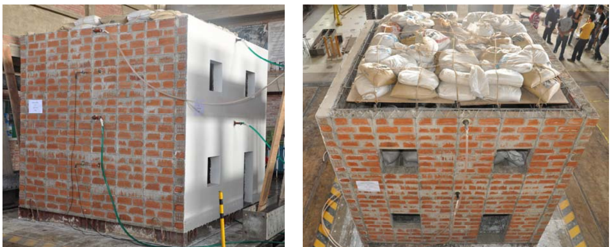
Figure 11. Construcción terminada, empleando mortero de cemento y con sólo 2 paredes enfoscadas y la sobrecarga de los forjados correspondiente a construcción media.
