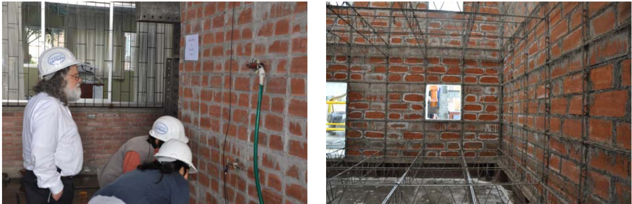
Figura 14. Al no haber aparecido grietas, se hace una búsqueda intensiva de posibles fisuras, tanto por el exterior como por el interior del prototipo, donde las Costillas AllWall de 150mm sobresalen 3,5cm del grueso del muro de ladrillo hueco de 11,5cm de ancho.
