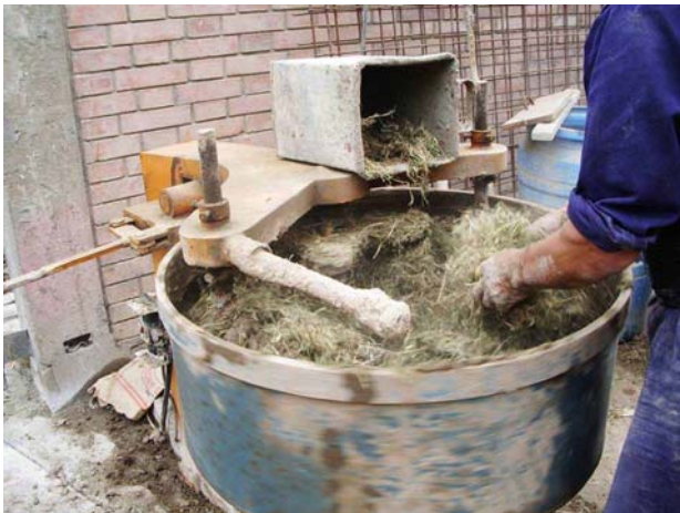
Figure 3. Preparación del muro de adobe y sus piezas de 24x12x6cm.
