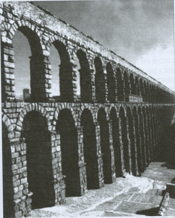
Fig. 1. El arco como almacén de tensión. Arcos equilibrados entre sí, trabajando sólo a compresión y dispuestos en el plano vertical, del Acueducto romano de Segovia.
