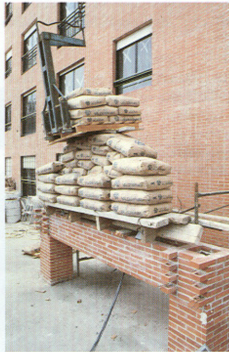
Fig. 3b.—Prueba de carga en obra de los dinteles dobles.
