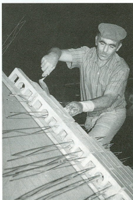
Fig. 2.—Tetrapilono Versión "2". Cubierta con hiladas verticales. Armaduras Murfor a través de los huecos del ladrillo Palau.
