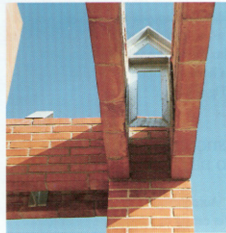
Fig. 4b.—Apoyos metálicos a la espera de soportar la cubierta prefabricada del tetrapilono.
