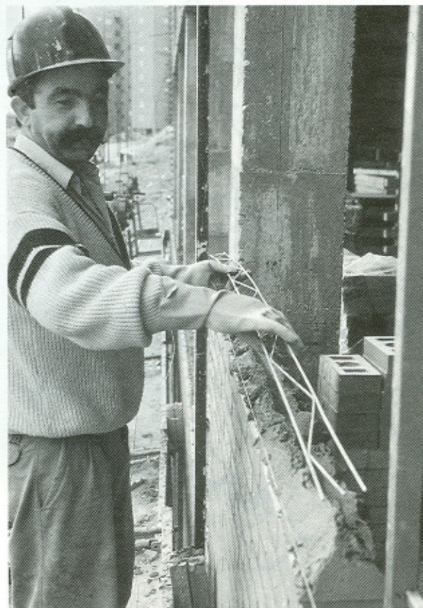
Fig. 9.—Construcción del cerramiento de "El Espinillo". a) Hoja exterior con armaduras cada 6 hiladas de altura. b) Colocación de la armadura Murfor en un tendel.
