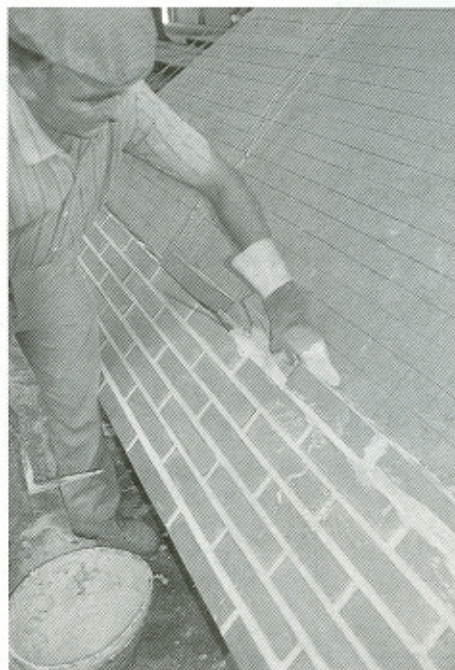
Fig. 2.—Tetrapilono Versión "1". Cubierta con hiladas horizontales. Armaduras Murfor dispuestas en los tendeles.
