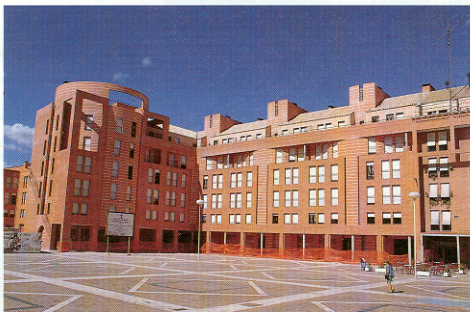
Fig. 13.—Análisis de las posibilidades de la fábrica armada considerando el cerramiento del edificio de la "Plaza de la Remonta".
