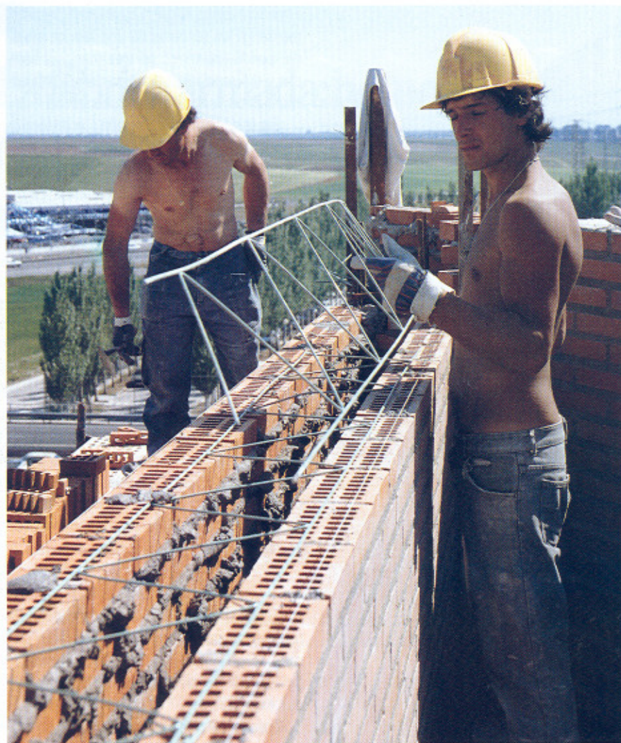
A caballo de dos hojas permite la construcción de sólidos muros .
