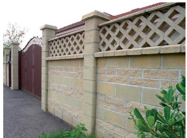
Figura 3b.- Empleo de mampostería de hormigón en muros de cerramiento con distintas geometrías, colores y acabados.
