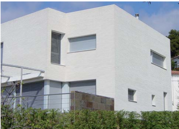
Figura 4b.- Empleo de la mampostería de hormigón en un cerramiento residencial con formato de ladrillo alargado de color blanco.
