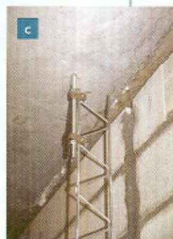
Abb. 7a AllWall-Befestigung Alpha unten; b) AllWall-Befestigung Beta oben; c) Teleskop-Befestigung der AllWall-Rippe an der oberen Deckenplatte.
