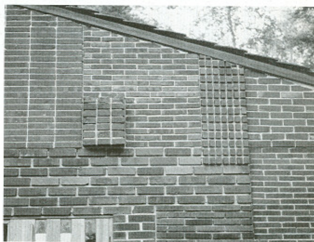
CASA EXPERIMENTAL EN MUURATSALO, FINLANDIA. ALVAR AALTO
